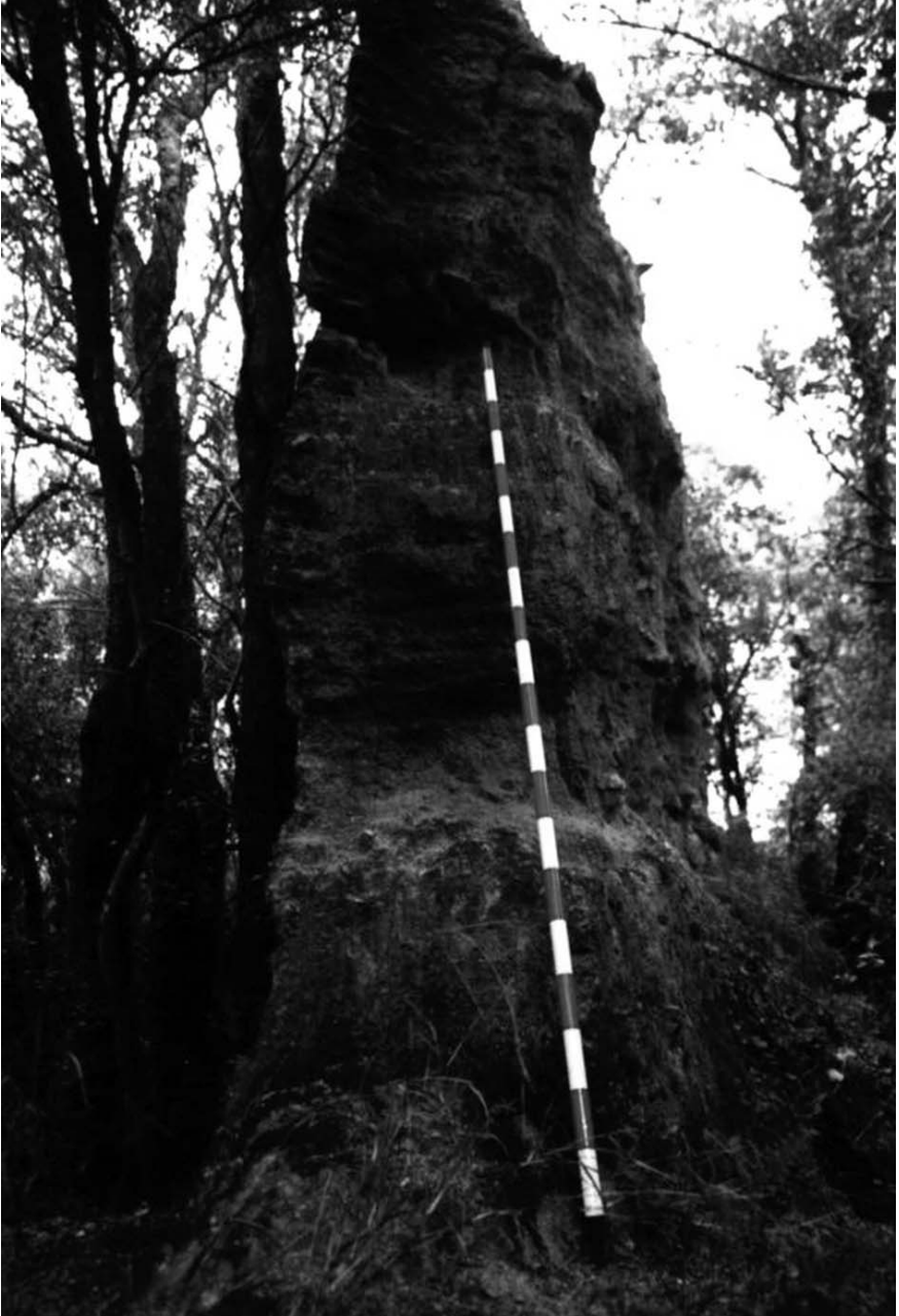
Mur de tàpia del costat de llevant.
