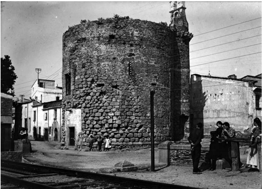
Perspectiva de la torre del Consell amb algunes obertures a la planta baixa que modificaven la volumetria inicial de la fortalesa. Dècada de 1920. (BPGP)
