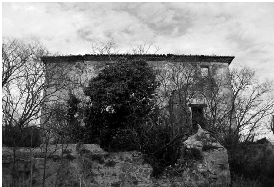
Façana est de la casa forta de Menola.
