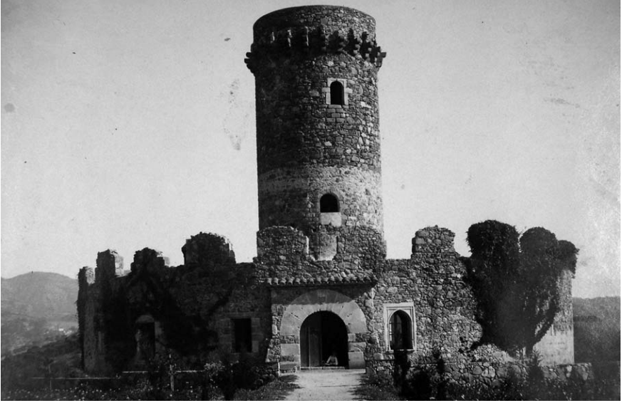
Torre dels Encantats, a Arenys de Mar
