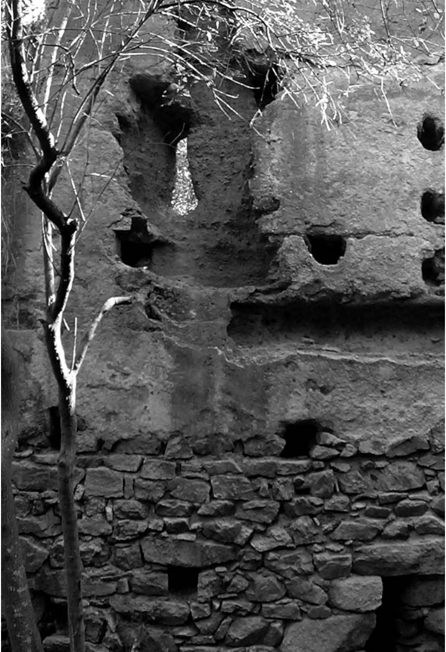
Costat nord des de l'interior.
