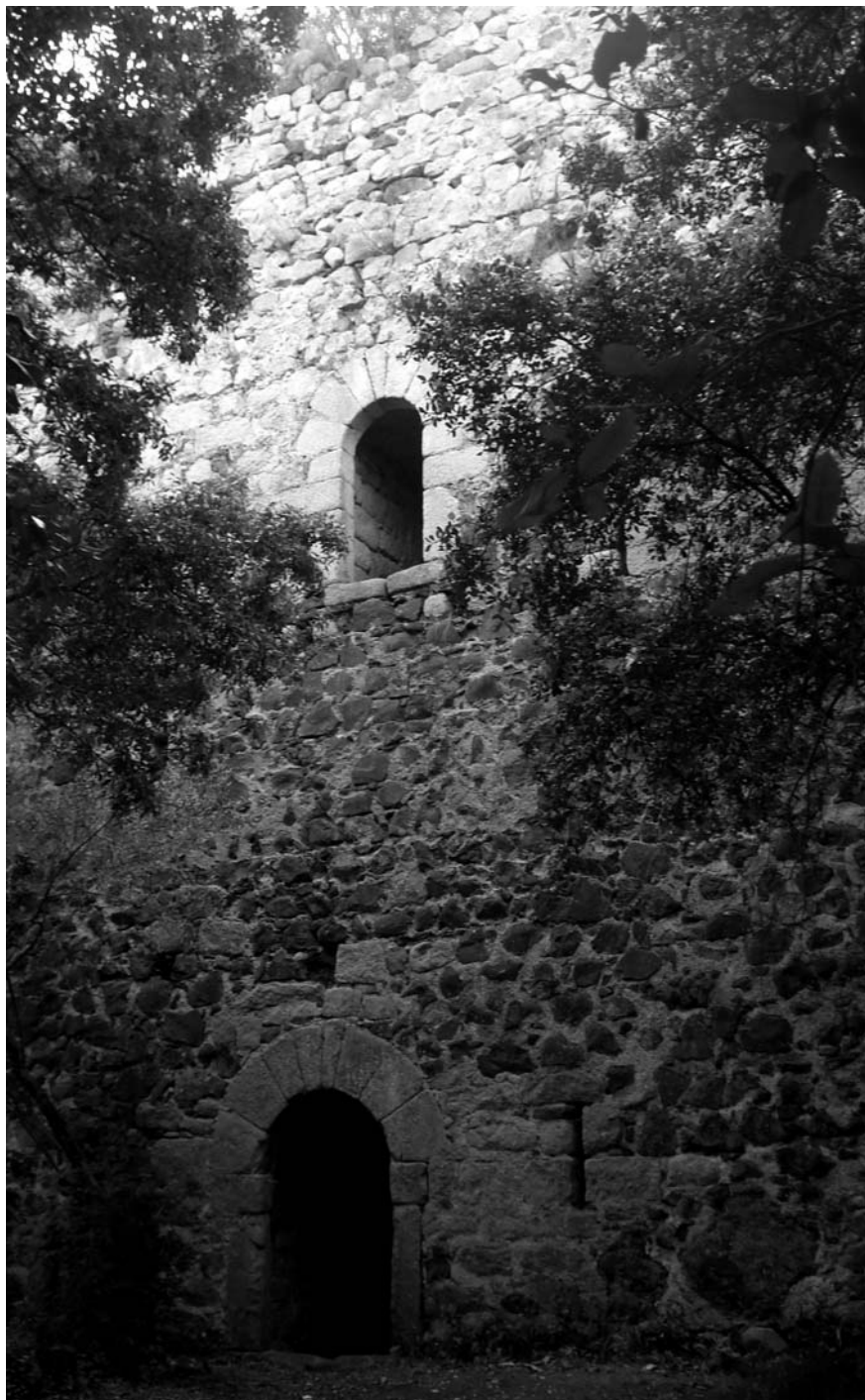
Torre de l'Esparra o Roqueta
