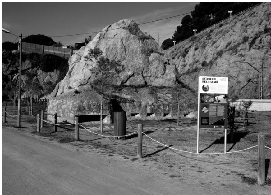
Vista lateral del búnquer després de l'actuació. Fotografia de David Castañeda
